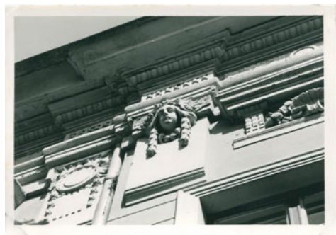
Detalj fasade zgrade Medicinske škole, Slavonski Brod, 1976. Foto Crnković
