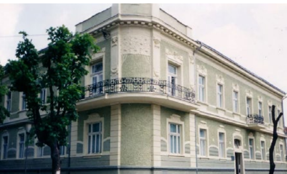
Zgrada Državnog arhiva u Slavonskom Brodu
