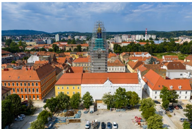
Pogled na crkvu Presvetog Trojstva s franjevačkim samostanom tijekom obnove u središtu karlovačke Zvijezde, lipanj 2025.
